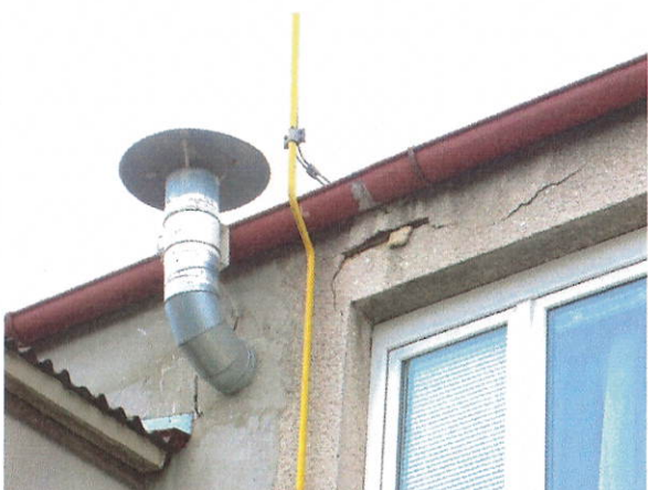
č. 38 – 40 Detaily poškození fasád, pavilon B
