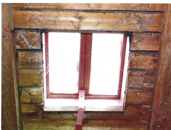
č. 26 – 27 Podstřeší, detaily konstrukce krovu, podbití střešního pláště a střešního okna
