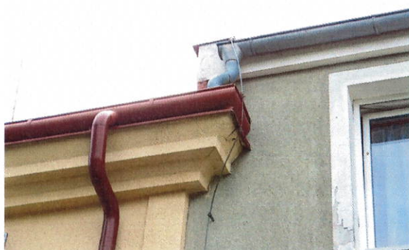
č. 36 – 37 Detaily spojení střešní konstrukce s obvodovým zdivem, přístavba pavilonu B, spojovací vestavba mezi pavilony A a B
