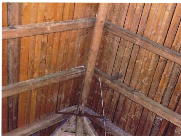
č. 26 – 27 Podstřeší, detaily konstrukce krovu, podbití střešního pláště a střešního okna
